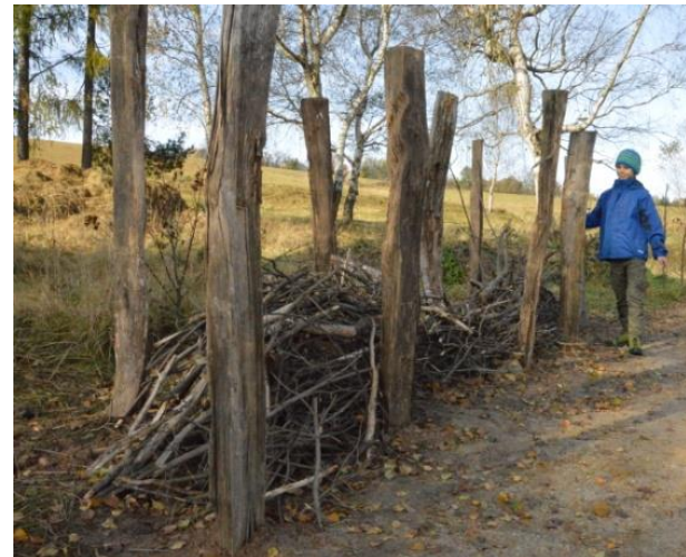
Totholzzaun im Bau am Lernort der Artenvielfalt/ Rübenau
